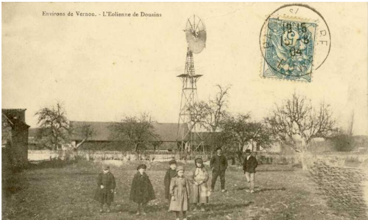
Éolienne de Douains
